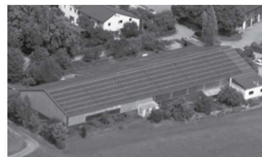
Gäufelden, Deutschland Montagesystem: K2 SpeedRail installierte Leistung: 31,85 kWp
