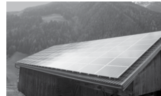
Weitenttal, Österreich Montagesystem: K2 Dachhaken, Schienen im Kreuzverbund installierte Leistung: 21,45 kWp
