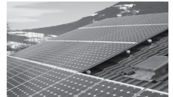
Aufhofen, Deutschland Montagesystem: K2 Dachhaken, Schienen einlagig installierte Leistung: 6,3 kWp
